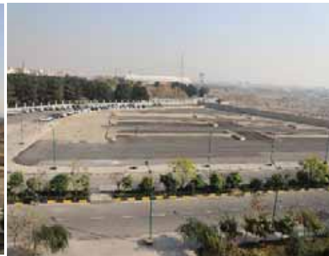
بعد از آسفالت‌ریزی
